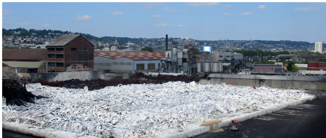
Film isolant posé sur les décombres des entrepôts
